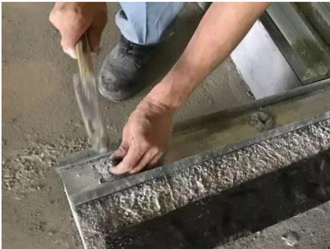
1 放线，安装天地龙骨
